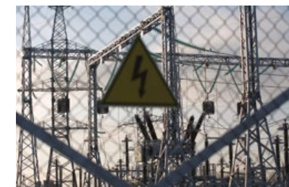
Реконструкция трансформаторной подстанции г. Севастополь
