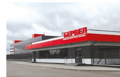
Завод высокопрочного крепежа «Бервел» г. Санкт-Петербург
