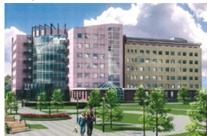
Перинатальный центр г. Петрозаводск
